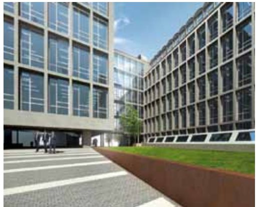
Zicht op het gebouw Empress Court (ex-Keizerin)
